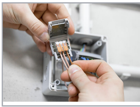
Verdrahtete Klemme in die Gelbox einlegen.
